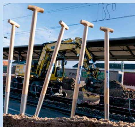
S-Bahn gerechter Ausbau des Bahnhofs in Schwetzingen.
