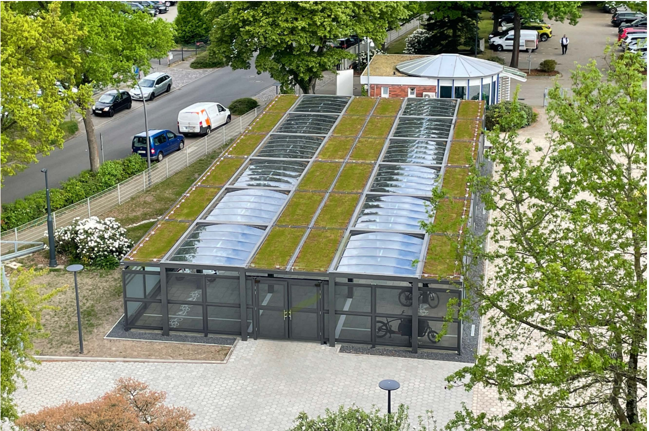
Fahrradabstellanlage Tectum mit Dachbegrünung in Eppendorf - Hamburg
